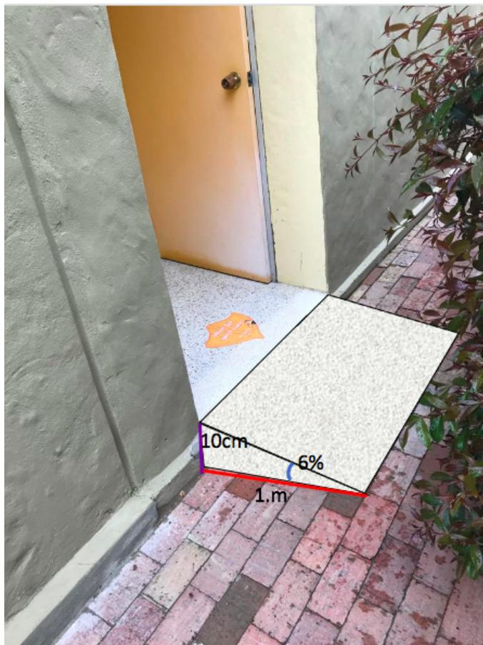
*Nota.* Para solucionar el problema de acceso, se propone una rampa que cumpla con las medidas indicadas en el manual para así poder generar una buena circulación inclusiva a los baños.
